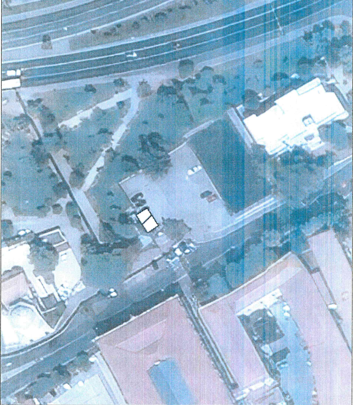
-Trafo Alanının Uydu Görüntüsündeki Konumu-
