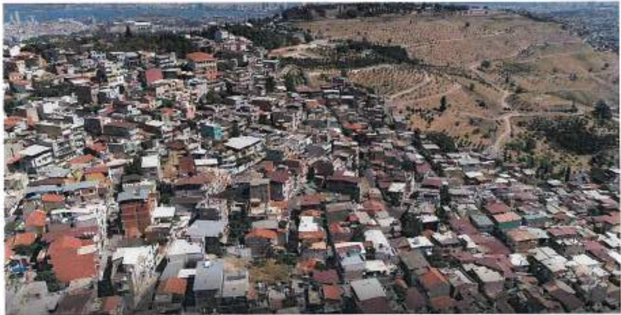
Resim 1. Hasan Özdemir, 19 Mayıs Mahallesi ve Heyelan Sahası Boşaltılmış Alan Çevresini Gösterir Hava Fotoğrafları
