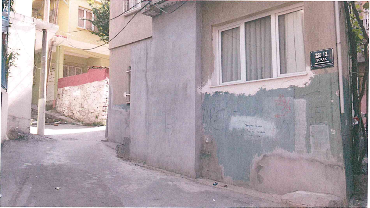
Fotoğraf : 729/3 Sokaktan Görünüş
